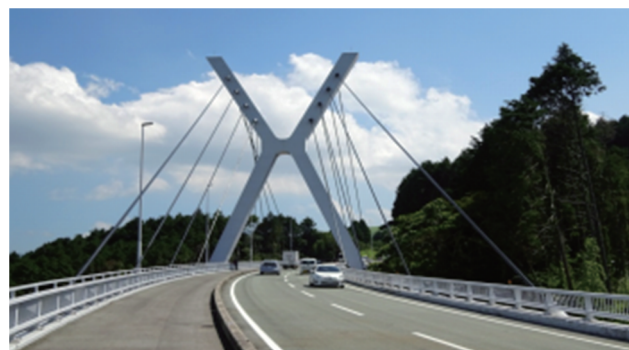
写真 復旧後の桑鶴大橋
