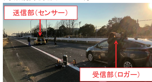
図1 無線通信を用いた実験の様子
