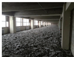
写真-1 床モルタルの研り
