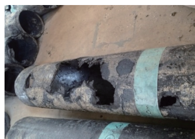
写真-2 洗浄試験で破損した管
