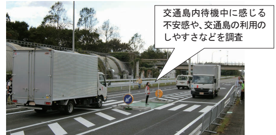
図2 二段階横断施設を仮設した通行実験
