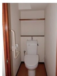
図-3 トイレ手摺の設置
