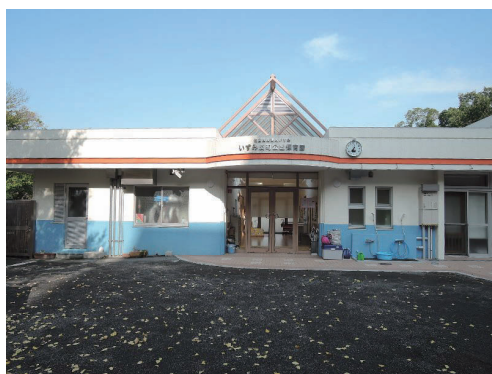
写真1 屋外時計を設置した保育所の設置事例 (横浜市反町公園)
