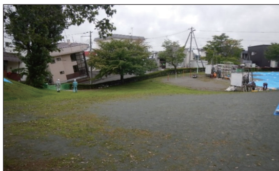
写真-1 地盤沈下の状況
