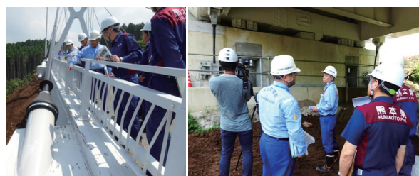
図-2 復旧した桑鶴大橋の現地説明会の様子
